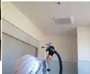
天井吹付け(例)
